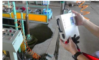
エア漏れ調査状況
