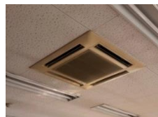
既存の空調設備
