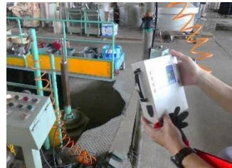
エア漏れ調査状況
