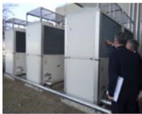
現場調査の状況
