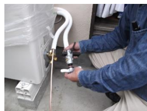
高効率ガス空調
