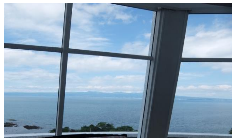
遮熱・断熱対策を実施した窓
